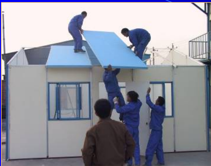
左上图：屋顶板安装
