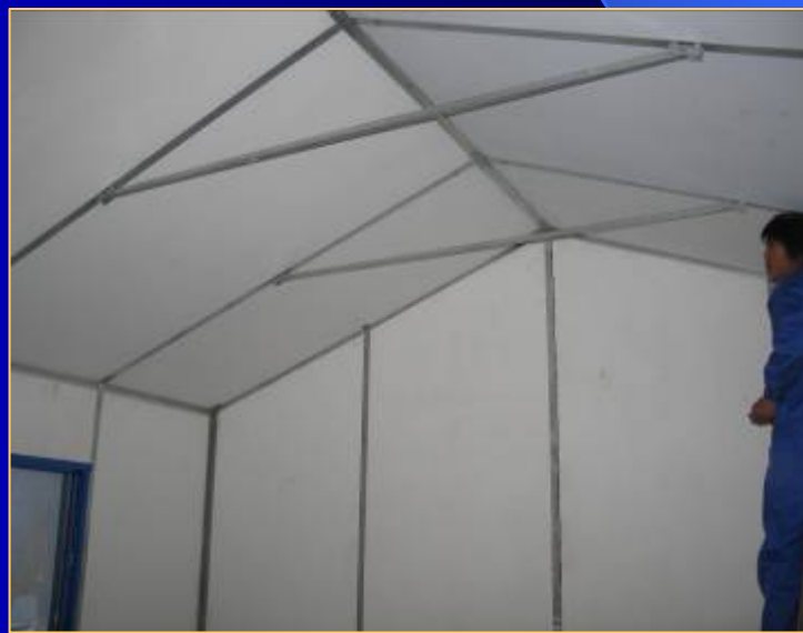
右上图：屋顶板的固定 和密封
