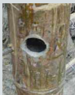
Mortar Fill Hole
