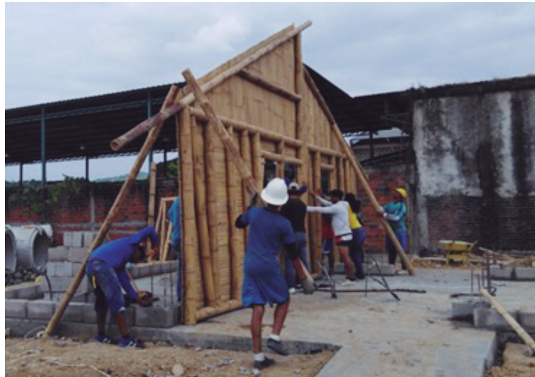
Figura 9. Construcción de estructura de bambú, Ecuador Fuente: INBAR, 2019
