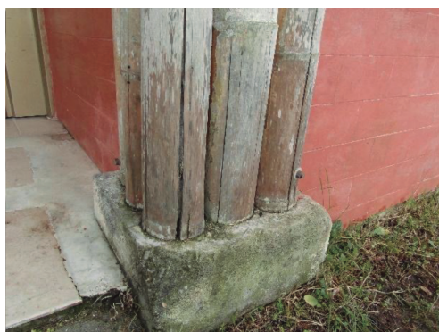
Figura 31. Pudrición por humedad
