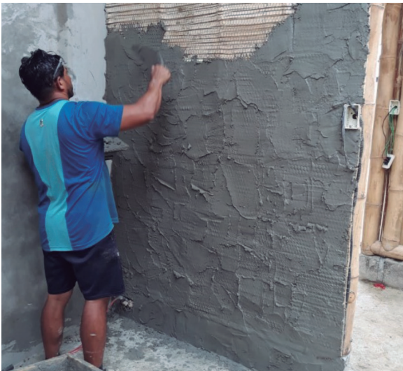
Figura 6. Bahareque encementado, Ecuador Fuente: INBAR, 2019
