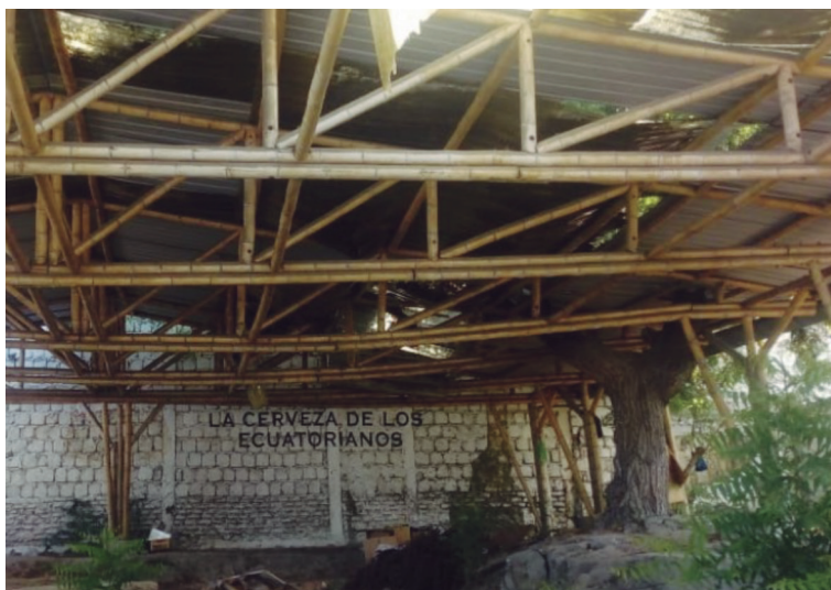
Figura 24. Estructura que presenta deformaciones estructurales
