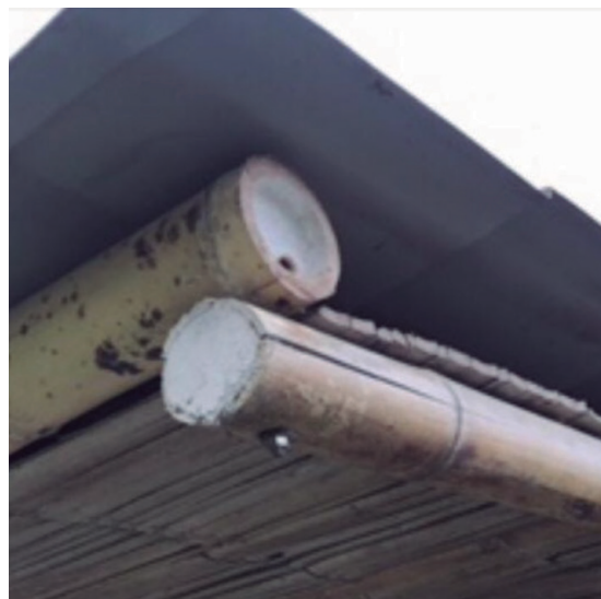
Figura 34. Rajaduras continuas de culmos Fuente: INBAR, 2021
