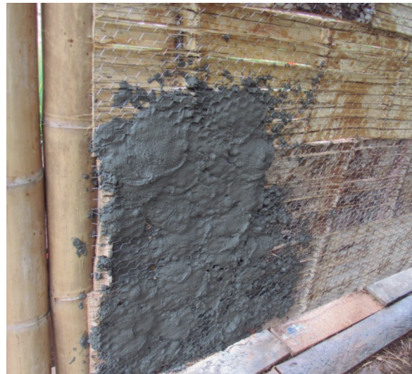
Figura 6. Bahareque encementado, Ecuador Fuente: INBAR, 2019
