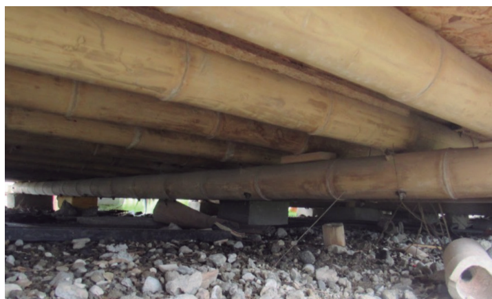
Figura 37. Culmos pandeados Fuente: INBAR, 2021
