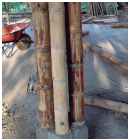
Figura 40. Reemplazo de la sección inferior de una columna
