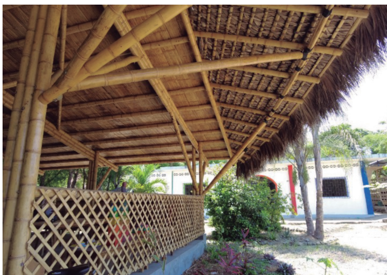
Figura 15. Extensos aleros para protección de bambú, Ecuador
