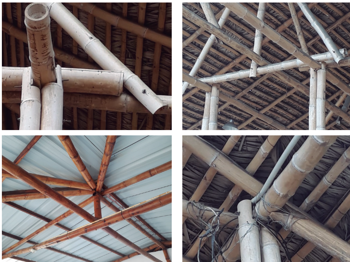
Figura 36. Uniones mal ejecutadas
