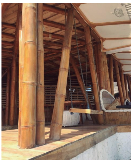
Figura 20. Estructura que presenta decoloración de los culmos
