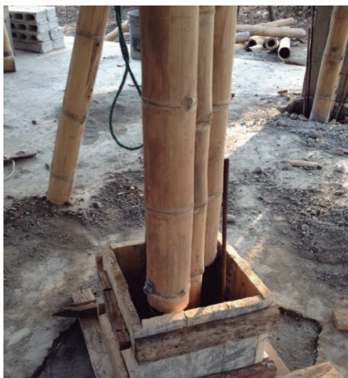
Figura 40. Reemplazo de la sección inferior de una columna
