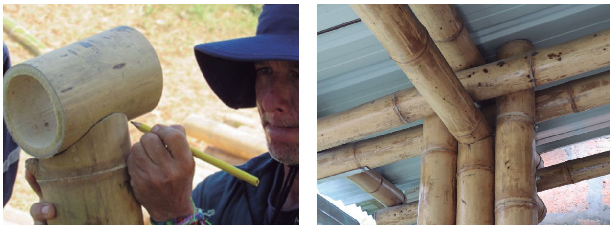
Figura 18. Cortes y uniones adecuadas
