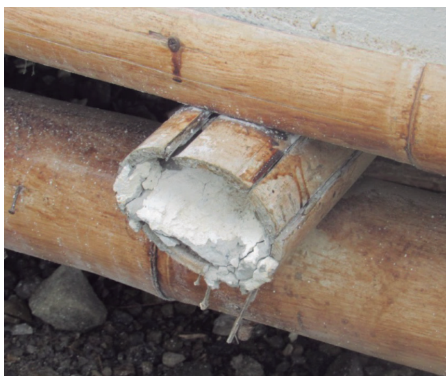
Figura 33. Aplastamiento de piezas estructurales Fuente: INBAR, 2021
