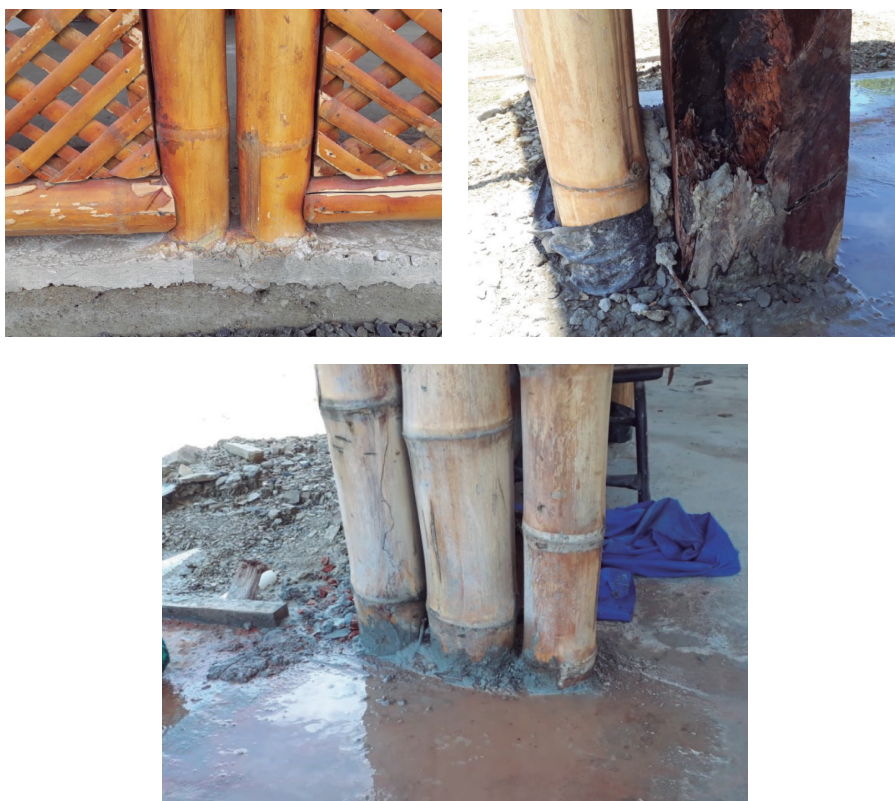
Figura 38. Piezas de guadua embebidas en hormigón Fuente: INBAR, 2021
