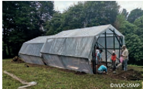
22. Se coloca los perfiles de aluminio en la parte frontal que falta recubrir y donde se instalara una puerta y una ventana de ventilación.
