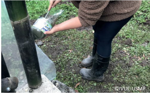
17. Relleno con mortero de los canutos en la base de los parantes de bambú.
