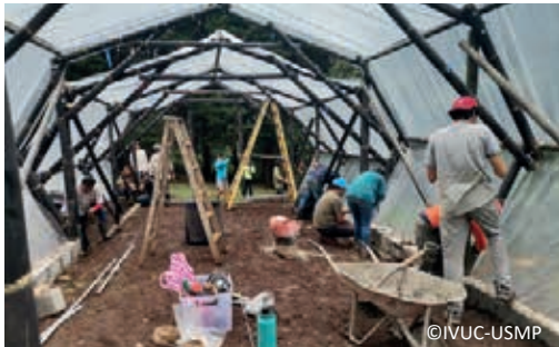
21. Relleno con mortero y revestimiento.
