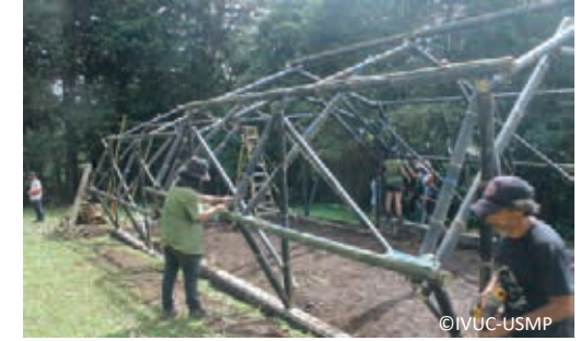
16. Colocación de las latillas de bambú encima de las correas para evitar el contacto directo del agrofilm con la estructura y los pernos.
