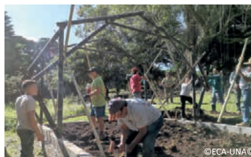
10. Colocación de los pórticos encima de las mechas de acero con arriostres temporales.
