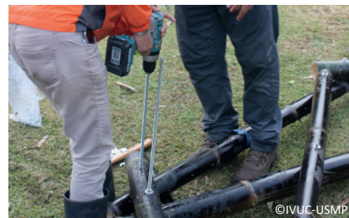
7. Colocación de los pernos pasantes.
