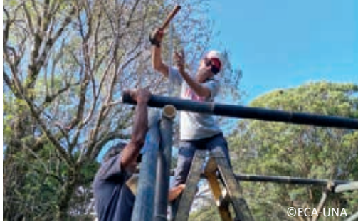
13. Conexión de las correas. También se podría utilizar tarrugos de bambú para esas uniones.
