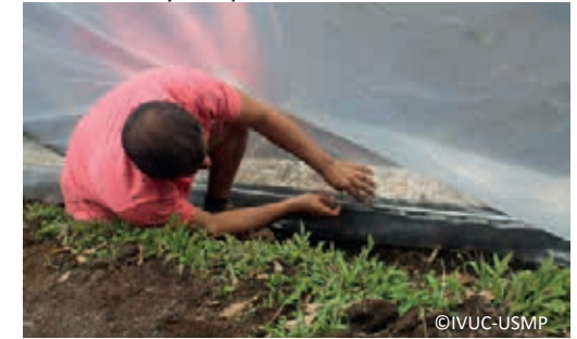
20. Colocación de los alambres en zigzag para asegurar el agrofilm.
