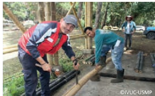
2. Fabricación de la latillas de Bambú con Dendrocalamus asper .
