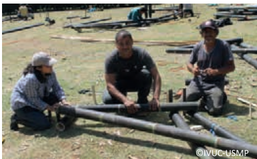
5. Armado de los semi-pórticos encima del trazado.
