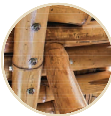
Perno pasante Ø 9mm o 12mm según su uso
