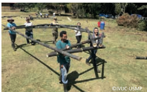
9. Transporte de los pórticos prefabricados.
