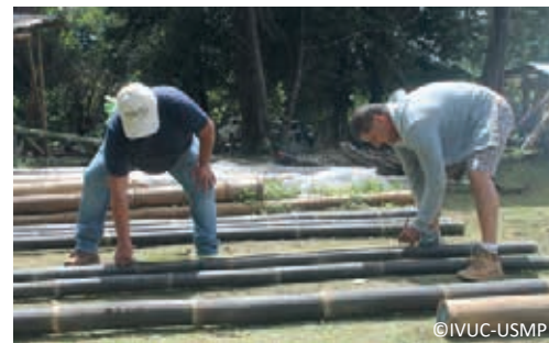
3. Medición y selección de las cañas de la especie Gigantochloa atrovioleacea .
