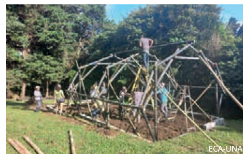
11. Colocación de las correas que unen los pórticos.
