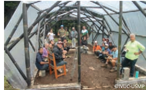
23. Estructura principal protegida.
