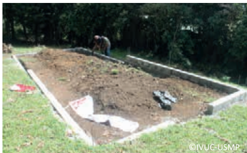
1. Cimientos con los fierros de construcción listos para recibir la estructura de bambú.
