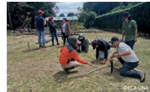
4. Trazado del pórtico en el suelo con cordeles.
