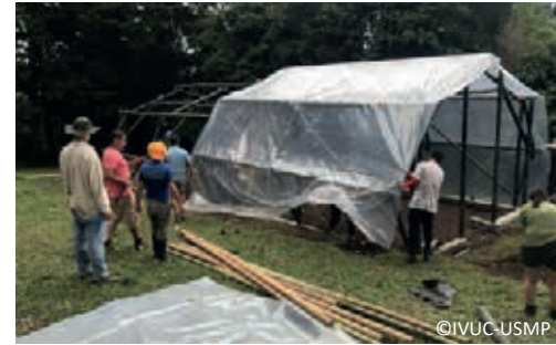
19. Despliegue del agrofilm por encima de la estructura.
