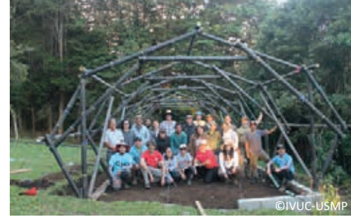
15. Estructura principal terminada.
