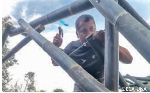
14. Una vez asegurada la plomeada de la estructura, se procede a la colocación de los arriostres.
