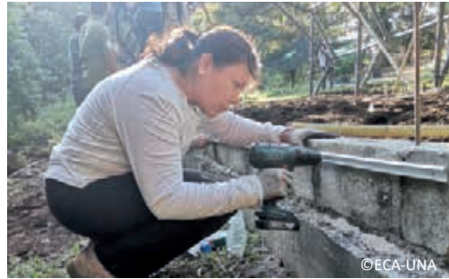
18. Colocación de los perfiles de aluminio en los sobrecimimentos.
